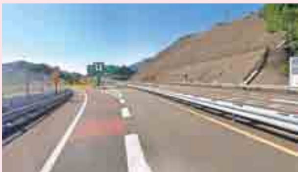
中部横断自動車道(新清水JCT付近)
